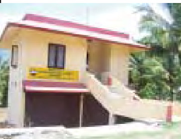
UA office Olavankara
